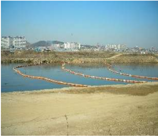
하천에 오탁 방지막 설치
